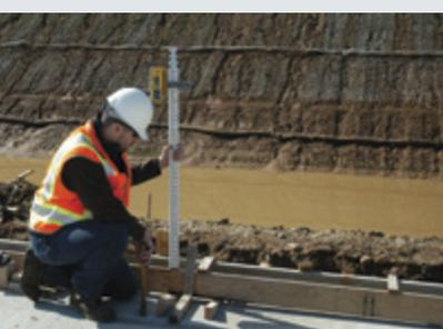
Spectra Precision® DR400 DigiRod™を使用すれば、回転式レーザで勾配をチェックする時に標尺は不要になります。読み取り値がデジタル表示されるレーザ受光器、レーザ距離計、内蔵チルトセンサがすべて一体となっているため、最大30度まで傾いた状態でも標尺を使わずに正確に勾配を割り出すのに必要な情報を提供します。
